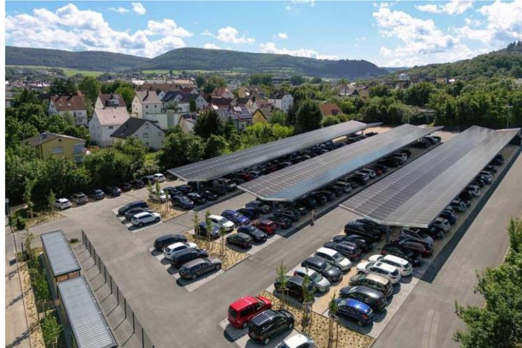
*Der Photovoltaik-Carport von MAPAL in Aalen erzeugt eine Gesamtleistung von 500 kWp.*
